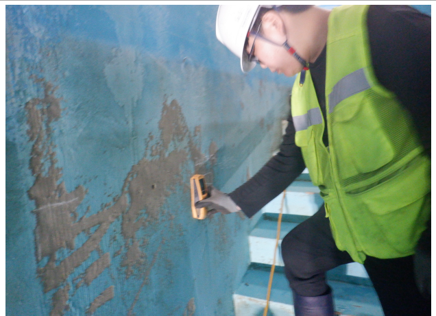
탄산화 깊이 측정
