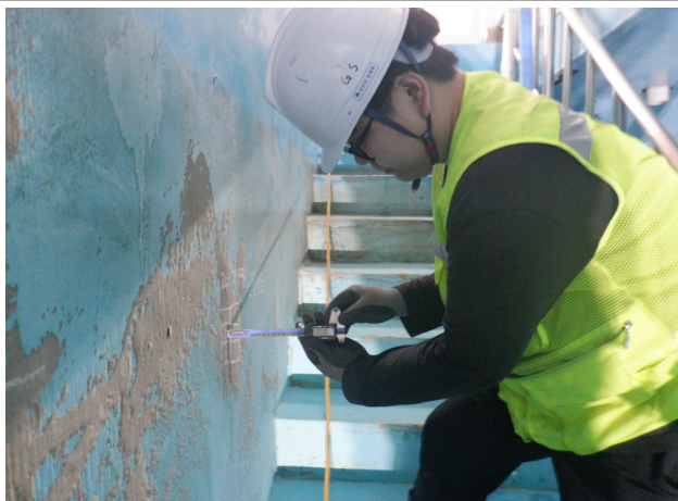
탄산화 깊이 측정
