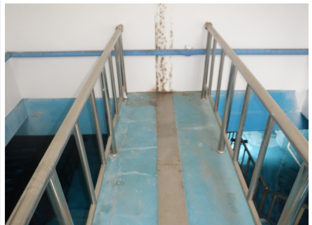
계단실 내부 안전난간 상태양호
